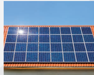
Photovoltaikanlagen -und Solaranlagenreinigung
